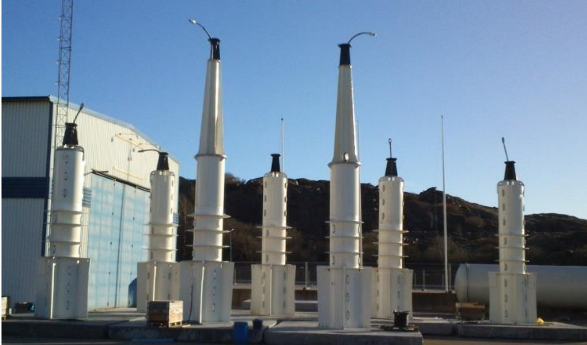
Figur 4. De två olika generatormodellerna innan installation i parkområdet.
