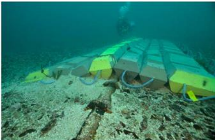
Figure 9 : Exemple de protection externe (Taormina, 2019)
