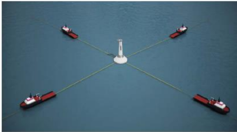
Figure 27 : illustration d'une opération de transfert et de dépose d'une structure d'éolienne (source Société du Parc de Guérande).
