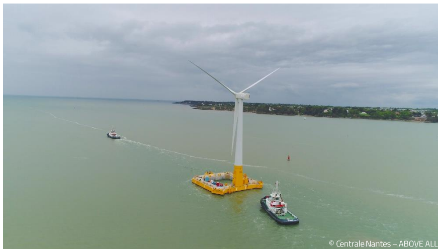
FIGURE 10 : REMORQUAGE DE L'ÉOLIENNE JUSQU'AU SITE SEM-REV.
