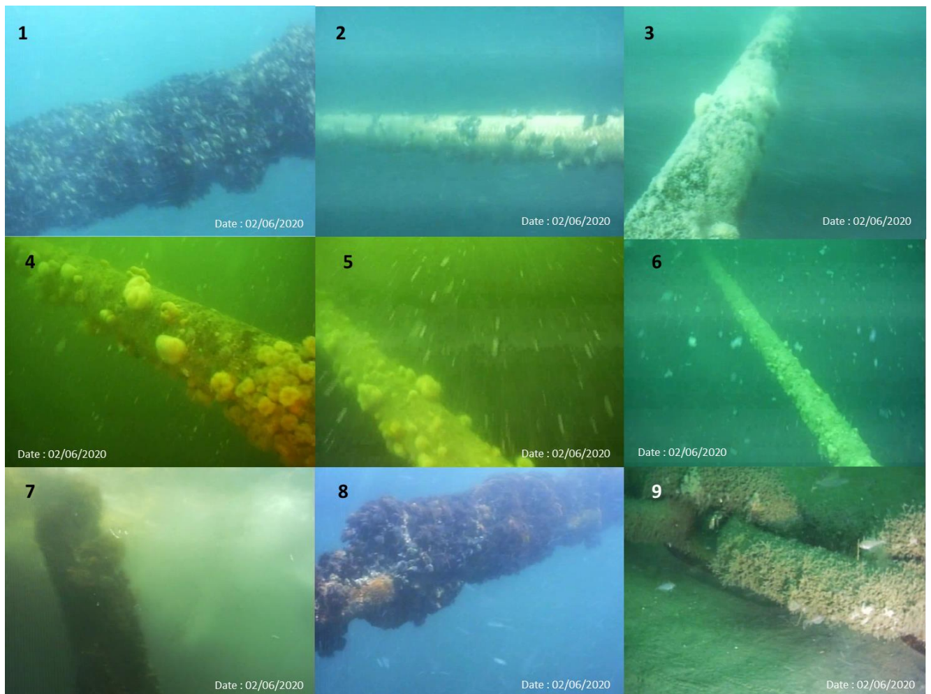
FIGURE 41 : PLANCHES PHOTOGRAPHIQUES REPRESENTATIVES DE LA BIOCOLONISATION DES LIGNES D'ANCRAGES (© BW IDEOL & CN – SEM-REV).
