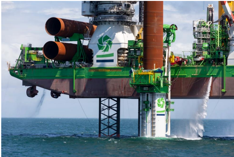
Figure 24 : Illustration du système MODIGA développé par DEME pour réduire le bruit à la source
