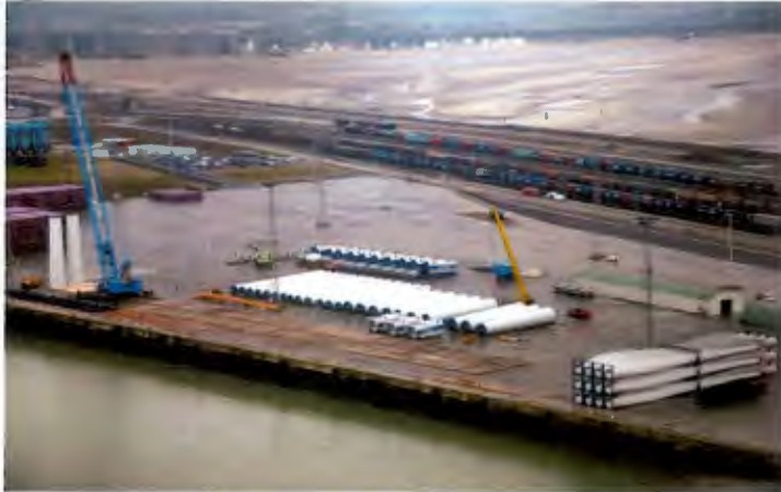
Foto 1: Voorbereidende werken in de haven van Zeebrugge
