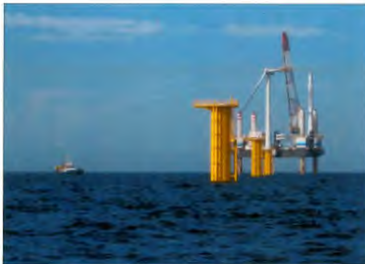
Foto 2: Installatie van windturbine door de JB114
