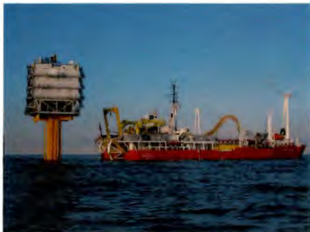
Foto 5: Installatieschip de Scagarac bij het OHVS
