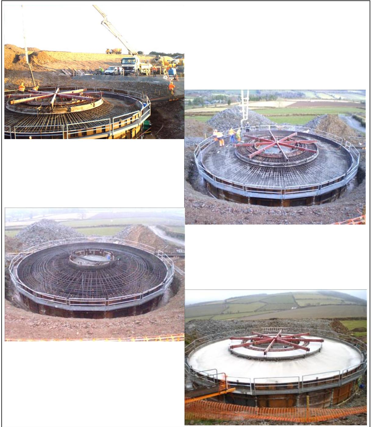
Figura 17: Imágenes del proceso de construcción de una fundación de aerogenerador
