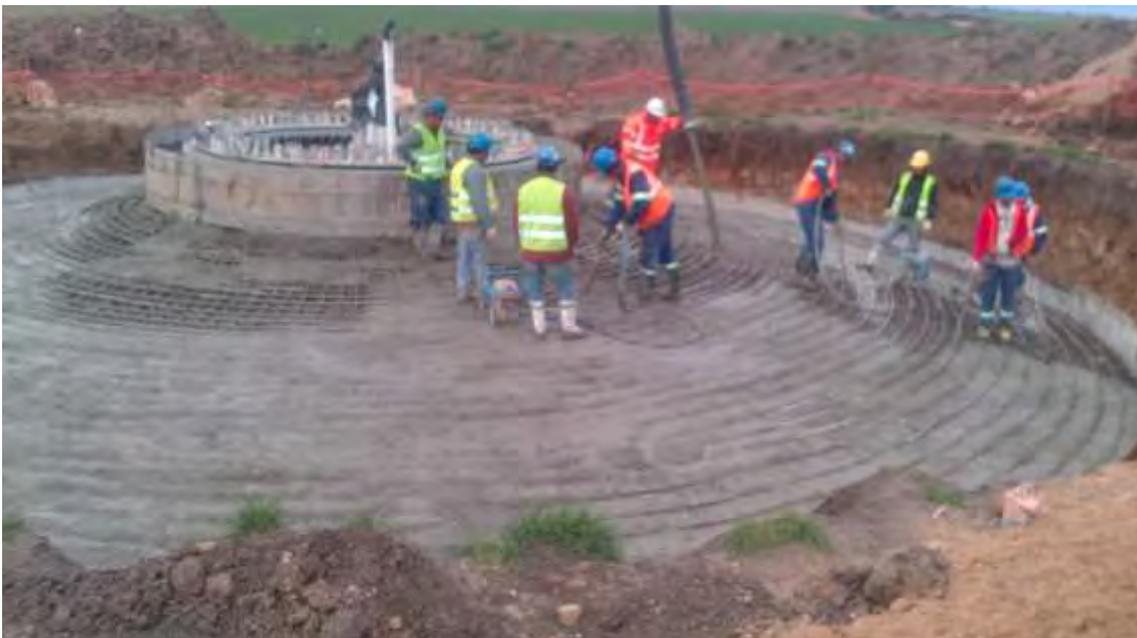
**Figura 3-5: Hormigonado de fundación**
