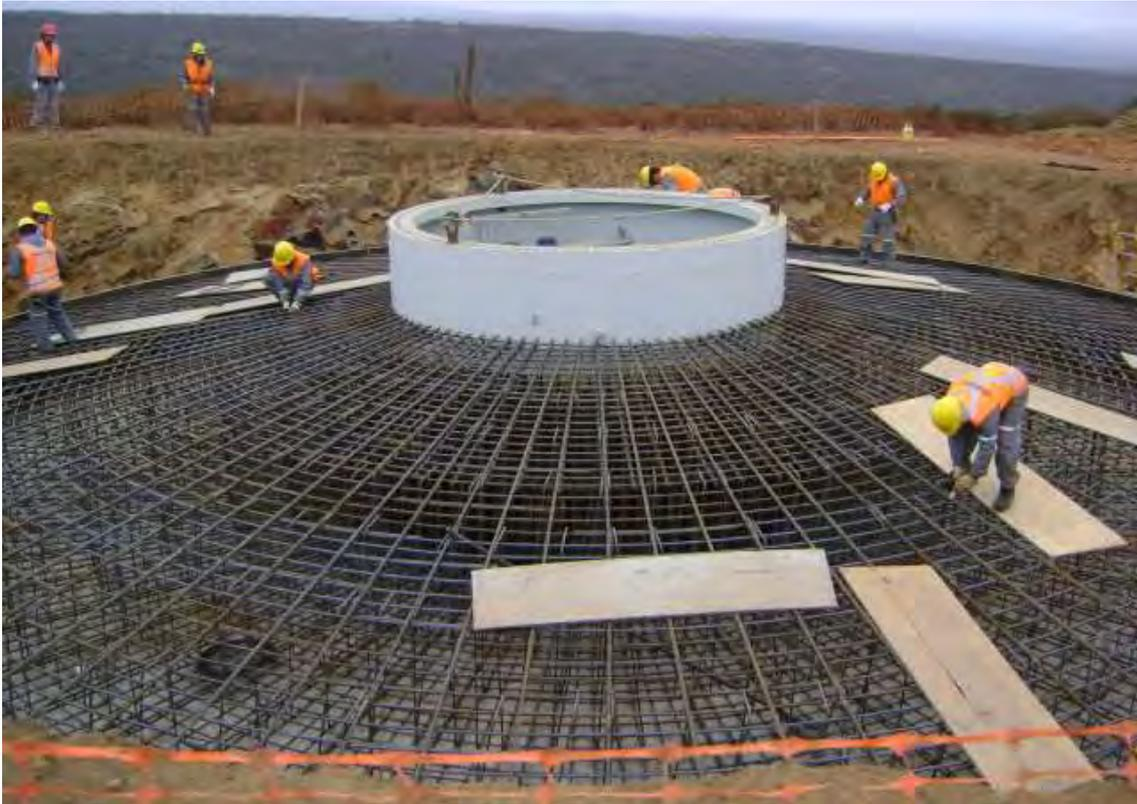
**Figura 3-4: Construcción de fundación de aerogenerador**
