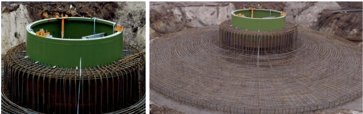
Fotografía 2-3 Construcción de la base del aerogenerador sobre la platea de fundación
