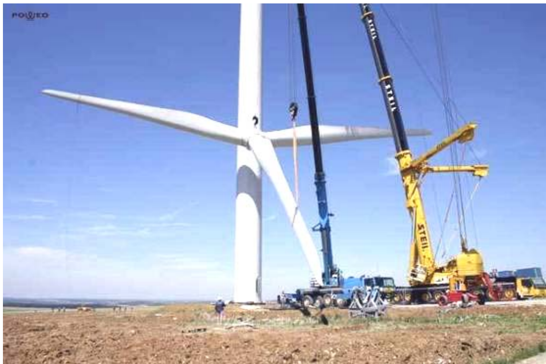
Fotografía 2-4 Montaje de las aspas
