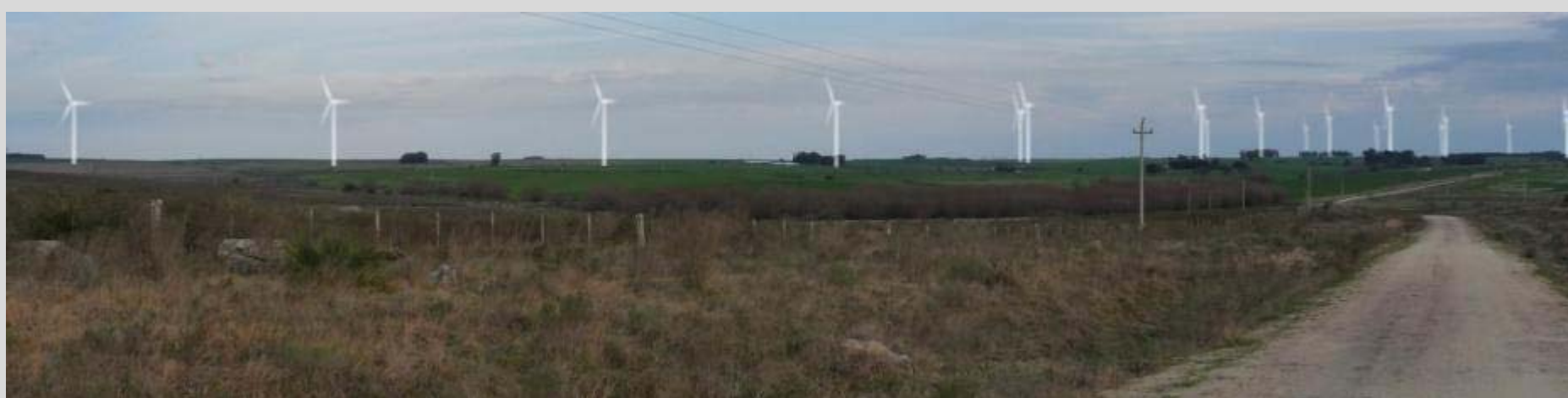
Figura 5–12 Punto 5 Vista del parque Eólico desde la Ruta 56 km8
