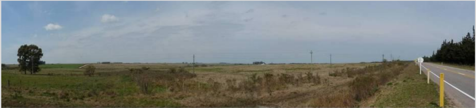
Figura 5-9 Punto 2 – Visual del Parque Eólico desde la Escuela N° 74
